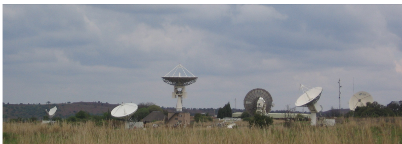
Figura6.4: O Centro de Aplicações Satelitais em Hartebeeshoek nas proximidades de Joanesburgo. Essas antenas especiais monitoram os satélites que passam sobre essa região e fazem o download de imagens usando ondas de rádio.
