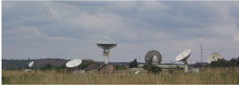
그림 6.4: 남아프리카 공화국 요하네스버그 부근 하르테비에스톡 (Hartebeesthoek) 에 있는 CSIR 위성 응용 센터. 특수 안테나들이 위를 지나가는 위성을 추적하며 무선 전파를 통해 이미지를 다운로드받습니다.
