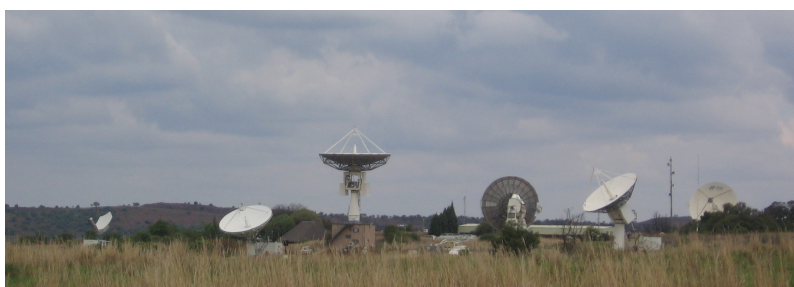
Figura 6.4: El CSIR Centro de Aplicaciones Satelitales en Hartebeeshoek cerca de Johannesburg. Satélites de pista de antenas especiales, ya que pasan por encima y descargar imágenes utilizando ondas de radio.
