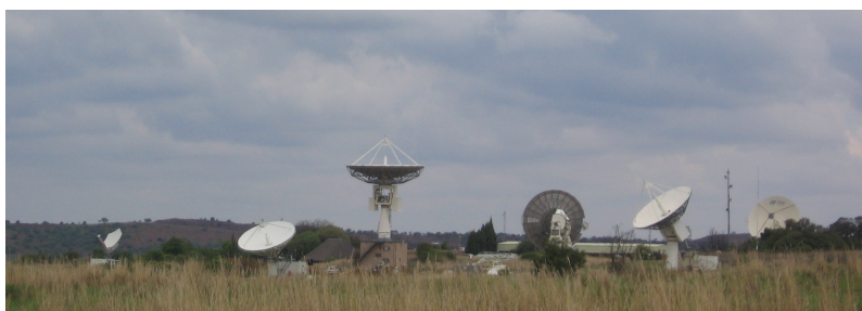
Fig. 6.4: Het CSIR Satellite Applications Center in Hartbeeshoek nabij Johannesburg. Speciale antennes volgen satellieten als zij bovenlangs passeren en downloaden afbeeldingen met behulp van radiogolven.
