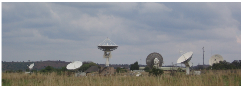
Fig. 6.4: Il CSIR Satellite Applications Center a Hartbeeshoek vicino a Johannesburg. Antenne specializzate rilevano il tracciato dei satelliti e scaricano immagini tramite onde radio
