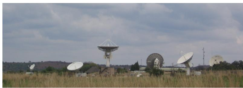
図 6.4: ヨハネスブルグ近くにある Hartebeeshoek の CSIR衛星アプリケーションセンター。頭上を通過し電波を用いて画像をダウンロードするような特別なアンテナ・トラック衛星である。
