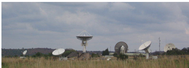
図 6.4: ヨハネスブルグ近くにある Hartebeeshoek の CSIR 衛星アプリケーションセンター。特別なアンテナは衛星が頭上を通過するときに追跡し、電波を使って画像をダウンロードします。
