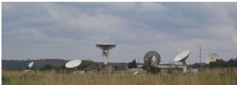
Figure 6.4: Le CSIR Satellite Applications Center à Hartebeeshoek près de Johannesburg. Des antennes spéciales persistent des satellites lorsqu'ils passent au-dessus et téléchargent les images en utilisant les ondes radio.
