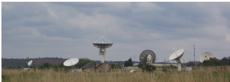
Fig. 6.4: Het CSIR Satellite Applications Center in Hartbeeshoek nabij Johannesburg. Speciale antennes volgen satellieten als zij bovenlangs passeren en downloaden afbeeldingen met behulp van radiogolven.
