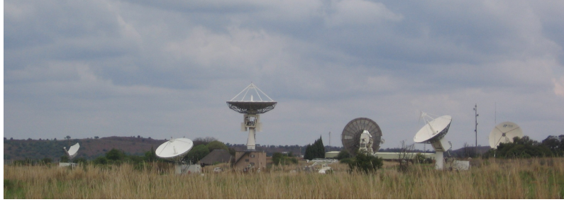
그림 6.4: 남아프리카 공화국 요하네스버그 부근 하르테비에스톡 (Hartebeesthoek) 에 있는 CSIR 위성 응용 센터. 특수 안테나들이 위를 지나가는 위성을 추적하며 무선 전파를 통해 이미지를 다운로드받습니다.
