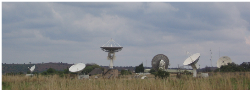
Figura6.4: O Centro de Aplicações Satelitais em Hartebeeshoek nas proximidades de Joanesburgo. Essas antenas especiais monitoram os satélites que passam sobre essa região e fazem o download de imagens usando ondas de rádio.
